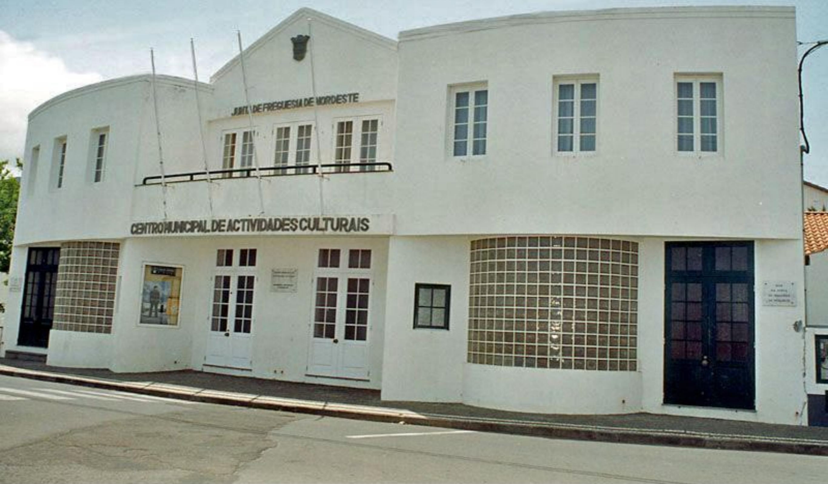
Sede da Junta de Freguesia de Nordeste e Centro Municipal de Actividades Culturais
