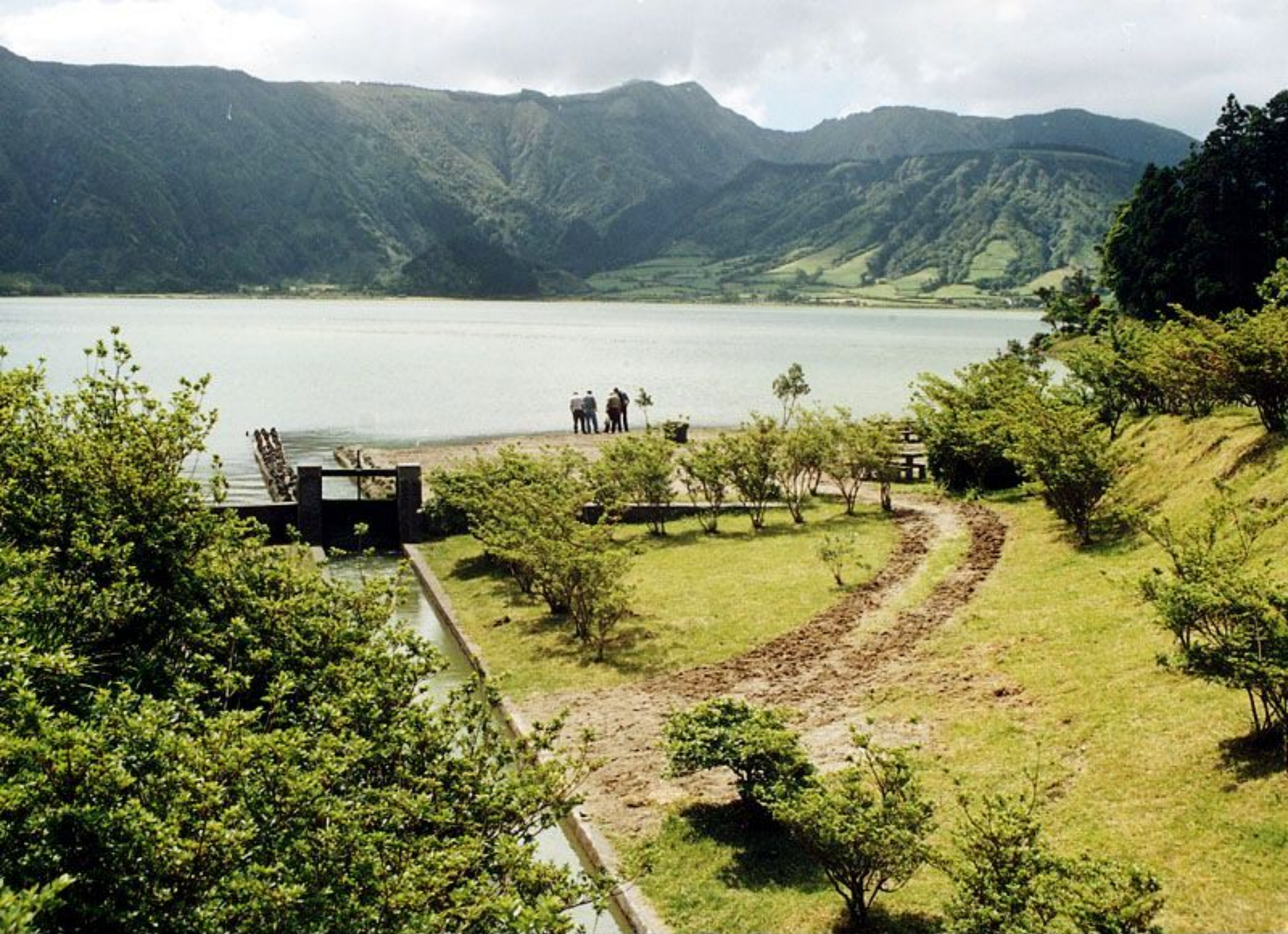
Tunel de Sete Cidades
