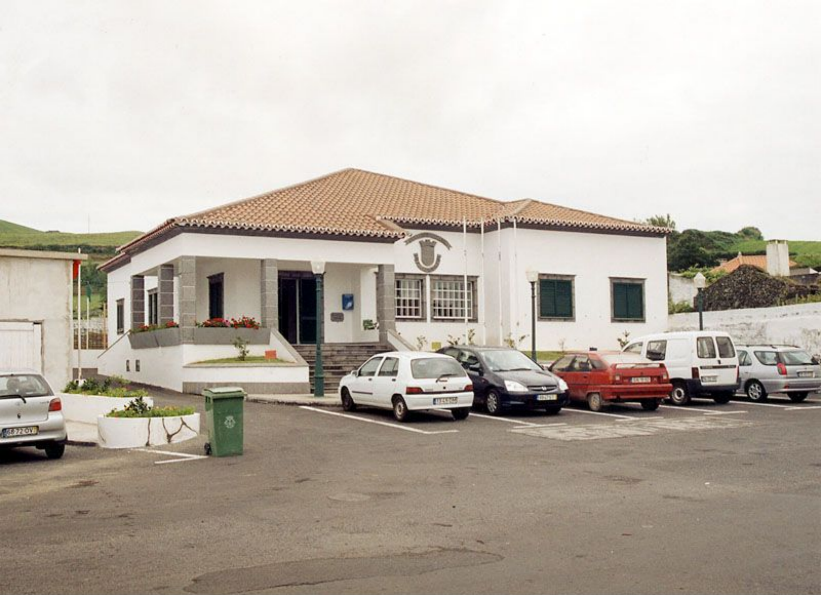
Sede da Junta de Freguesia
