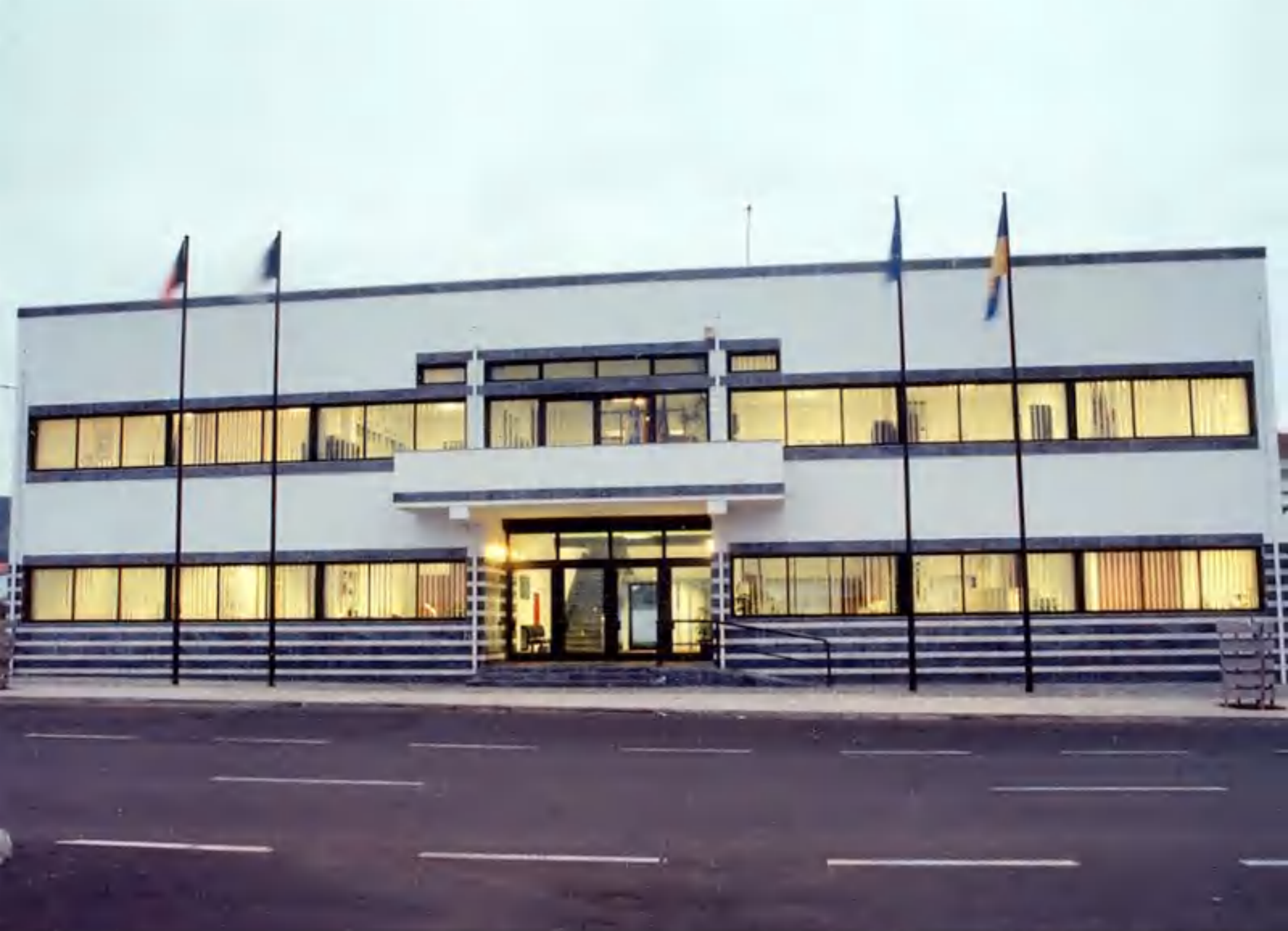
Sede da Junta de Freguesia de Santa Cruz - Praia da Vitória
