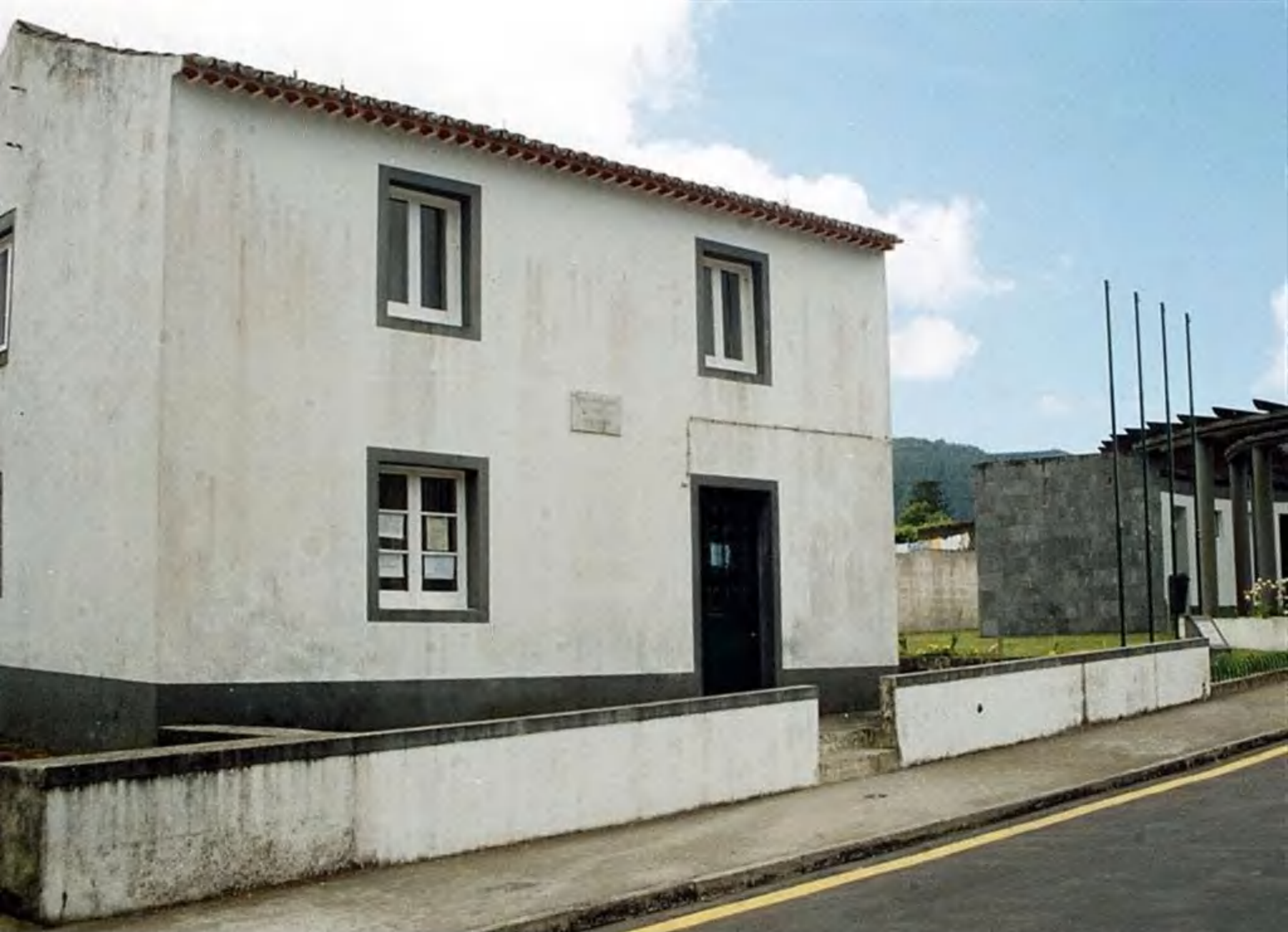
Sede da Junta de Freguesia
