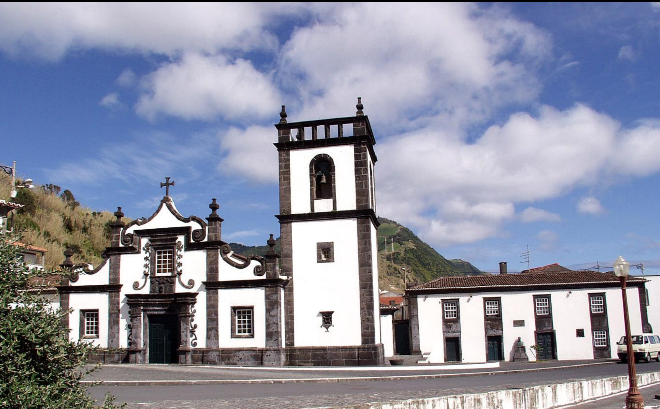
IGREJA Nª Sª do ROSÁRIO (Praça Velha) POVOAÇÃO AÇORES
