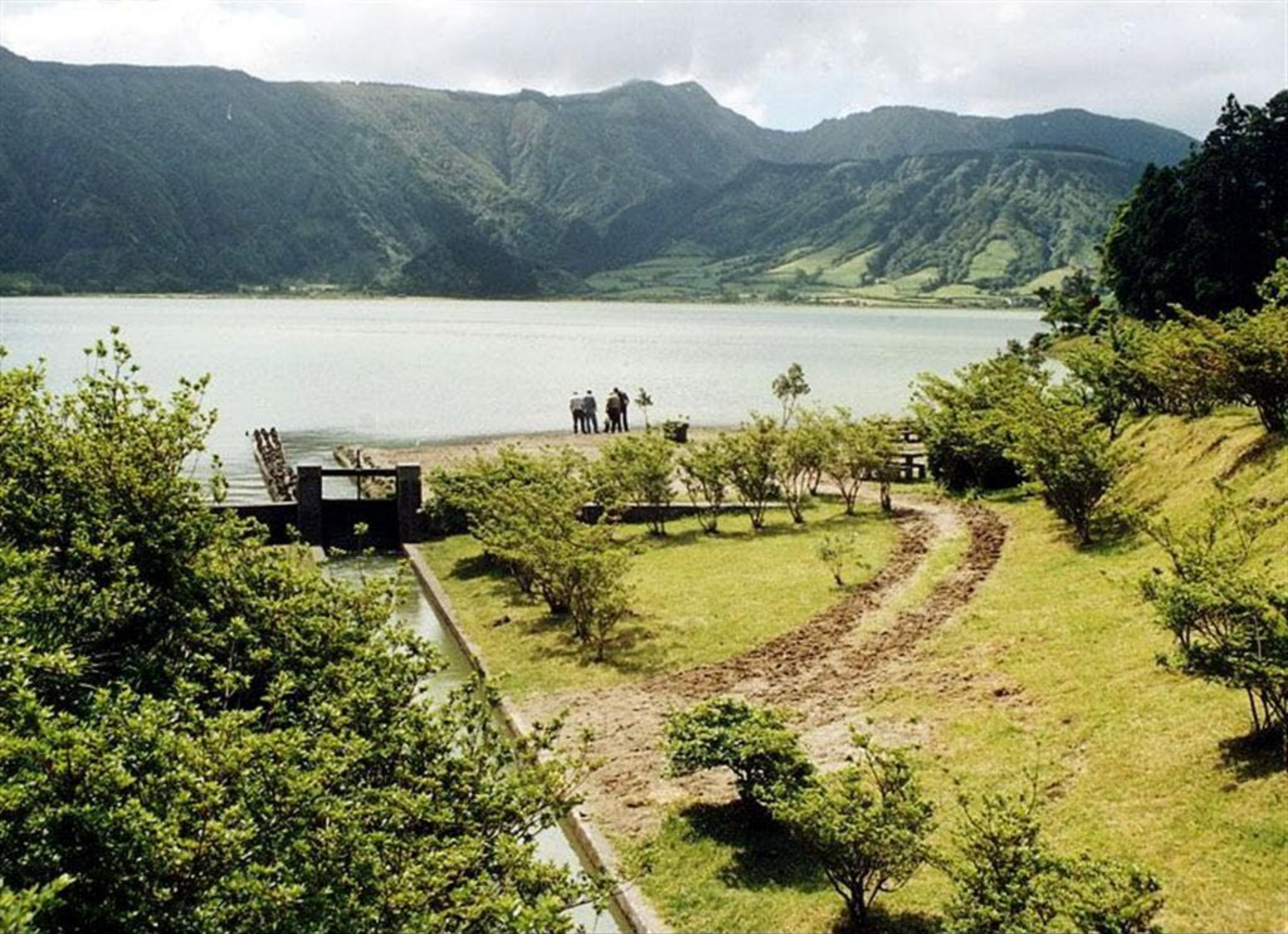
Tunel de Sete Cidades
