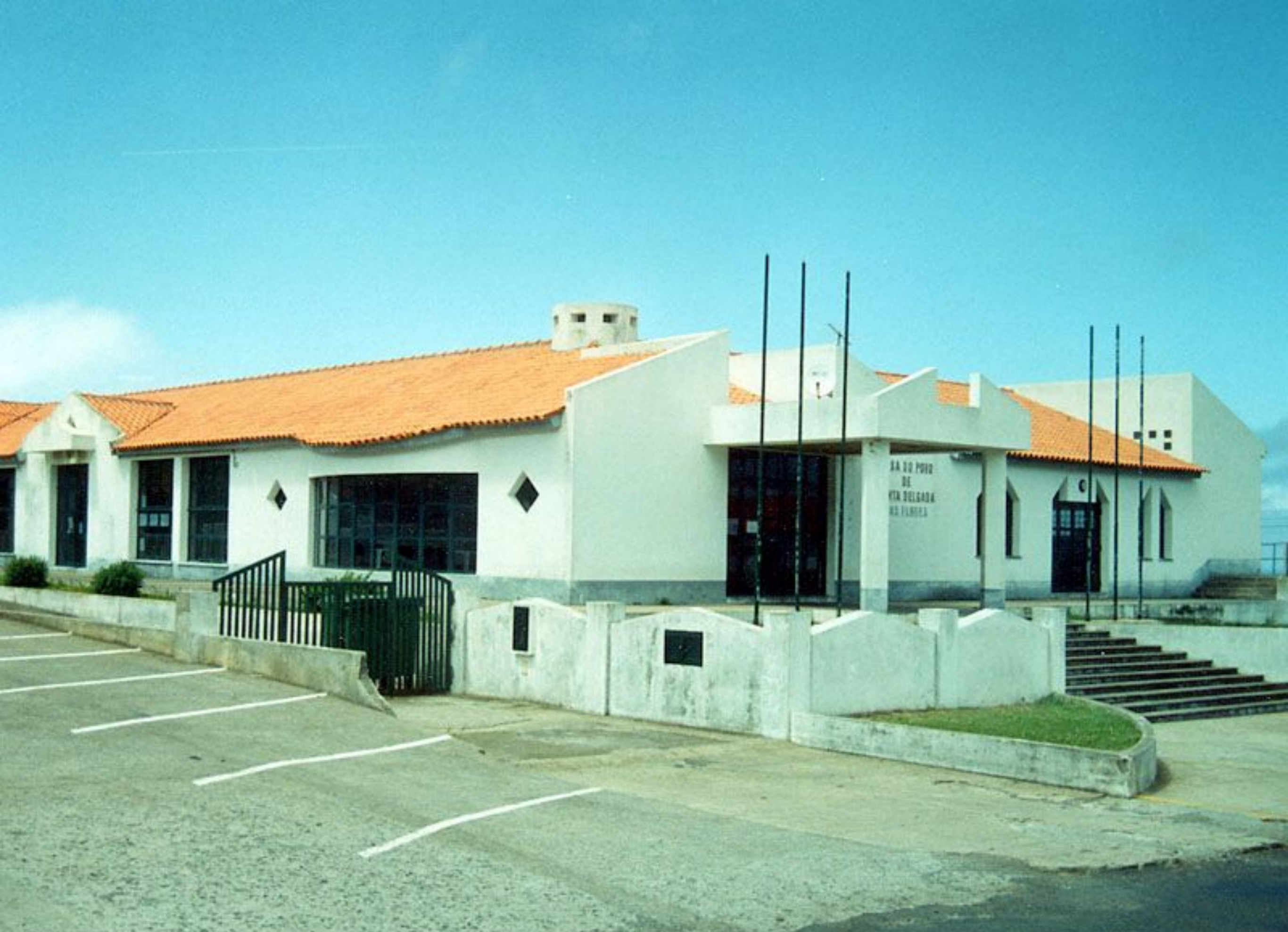
Sede da Junta de Freguesia - Polivalente da Casa do Povo de Ponta Delgada
