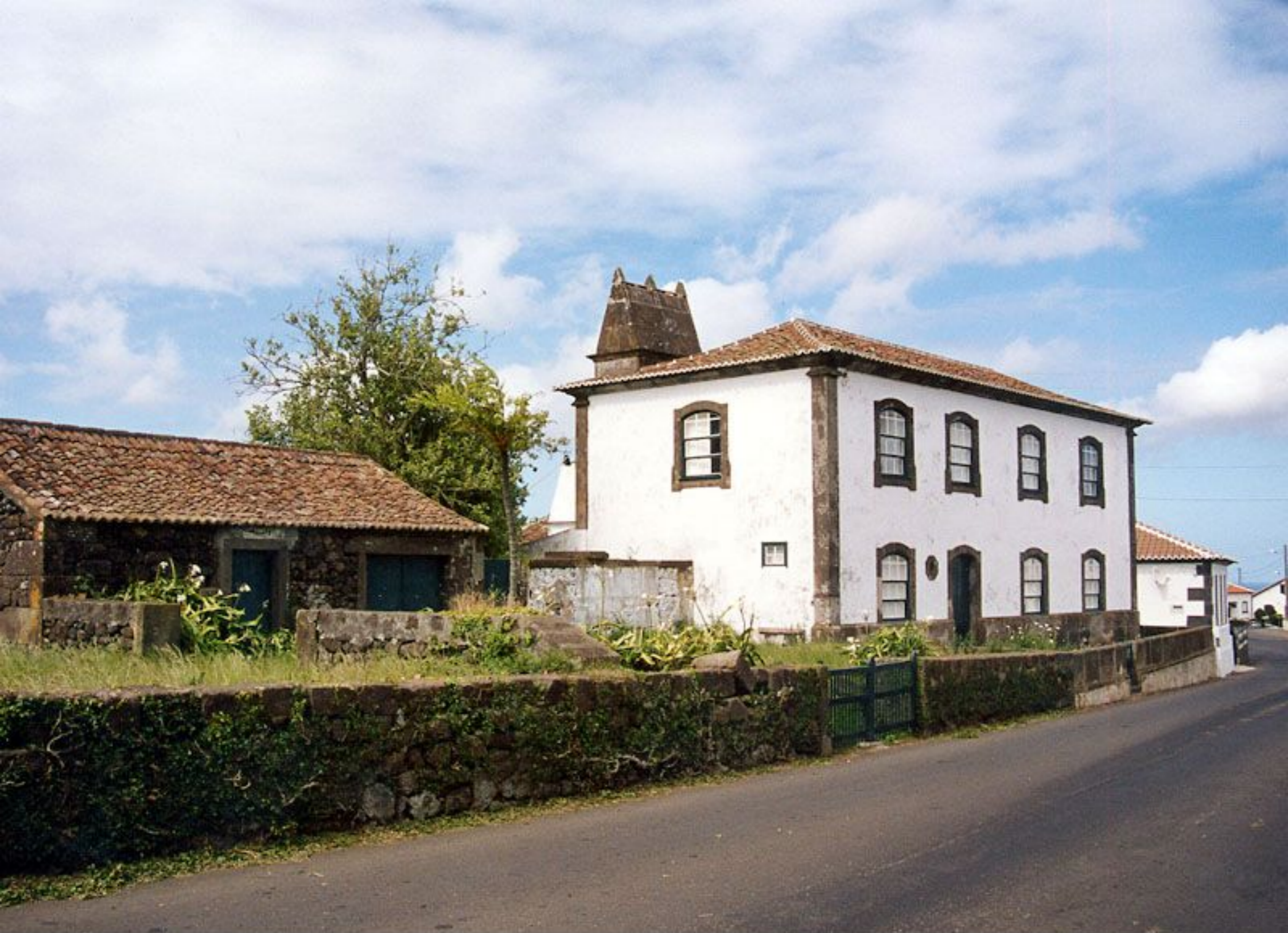
Casa Rústica de São Brás
