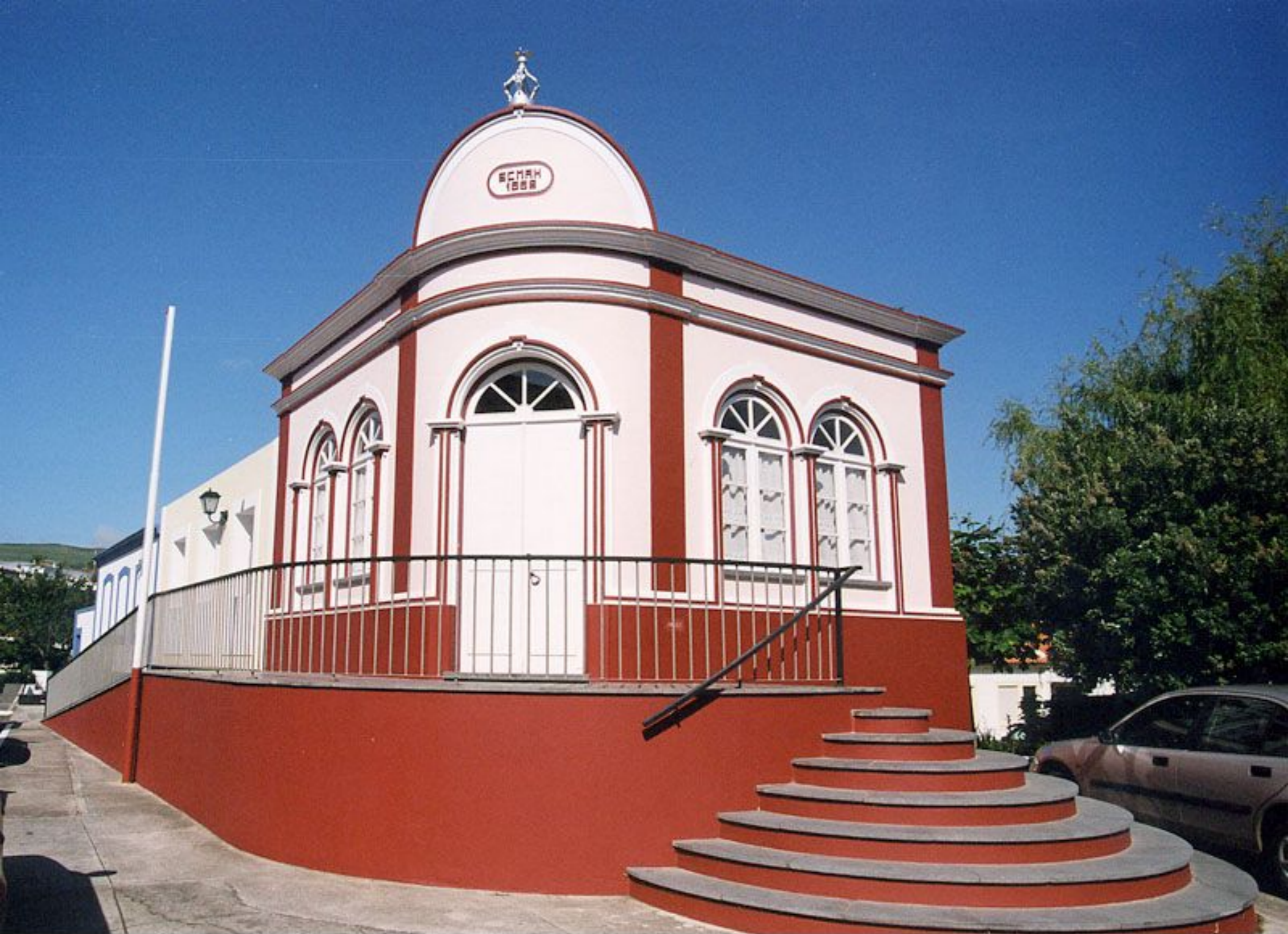
Império da Santa Casa da Misericórdia
