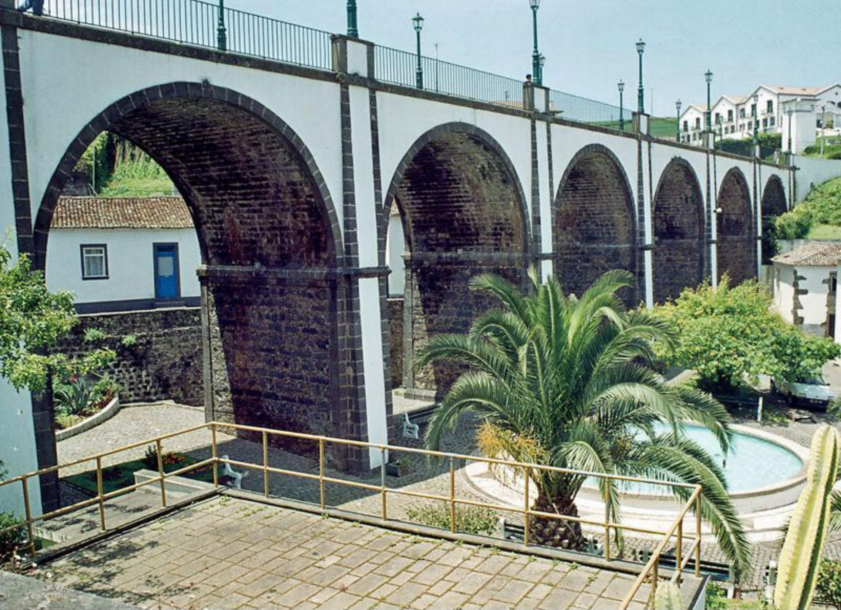
Ponte dos Sete Arcos
