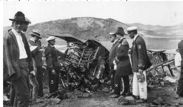
Fot. 6 – Destroços do avião Marechal Pilsudski na ilha Graciosa (Açores)
